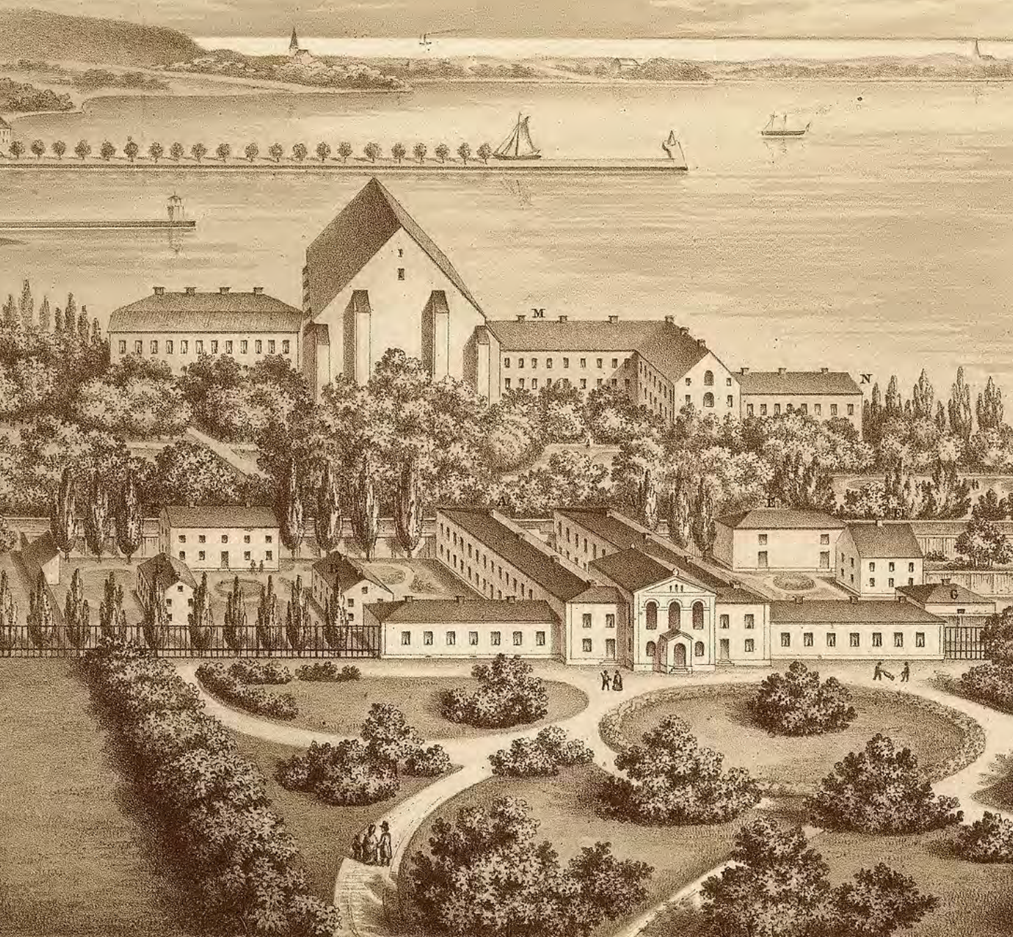
Litografi av Vadstena hospital, avbildat år 1861 i "Beskrifning öfver Wadstena Hospitalsbyggnader". Källa: WikipediaCommons
