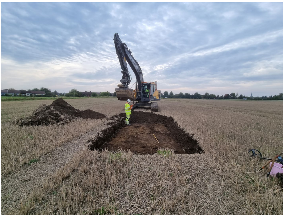
Figur 2. Inmätning av schakt och anläggningar.
