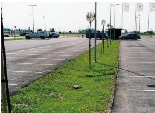
Figur 16. Infiltrationsstråk vid parkering. (Bildkälla: Stockholms vatten och avfall)
