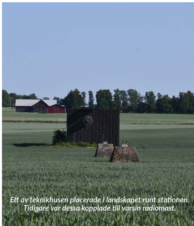
Rester efter den rasade masten.
