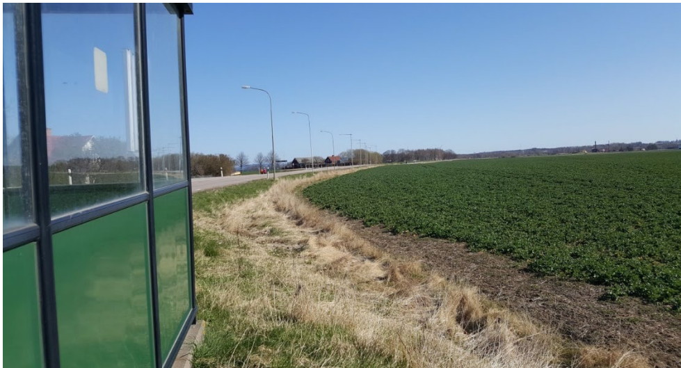
Figur 12: Motalavägen avgränsar planområdet till höger i bild. I bildens vänstra kant syns busskuren till bussbållplatsen
